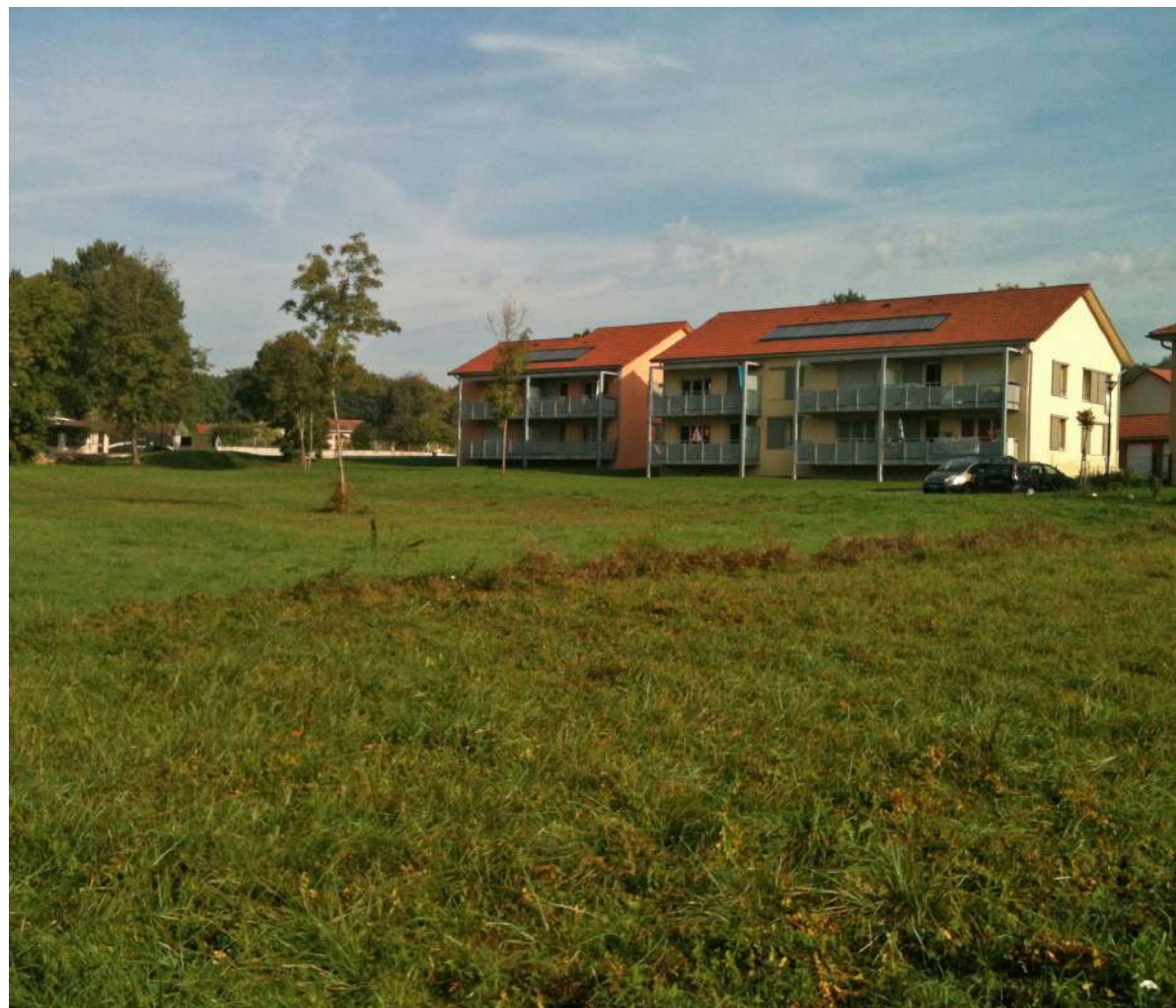
Logements collectifs, Porcieu Amblagnieu
