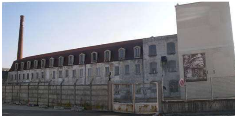
Projet de requalification de la friche Tréfinmétaux à Pont de Chéruy
